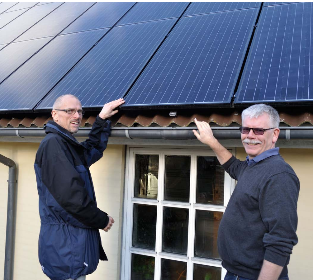
Markedsudvikler Jens Møller Goul fra Jebjerg nord for Skive er en af de husejere, som har monteret solcelleanlæg på sit hus. Det vejer ca. 600 kilo og fylder en stor del af hans sydvendte skråtag. Med på fotoet er bygningstaksator Peter Svendsen fra Topdanmark, der kan give gode råd om montering af solcelleanlæg og forsikringsforhold omkring anlægget. Foto: NærBrand
